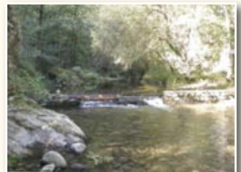
Mise en place d'un seuil piscicole en bois sur la Cance à Annonay
