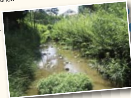
Après les travaux
