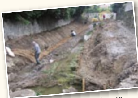
Travaux de restauration des berges - le Torrenson à Andance
