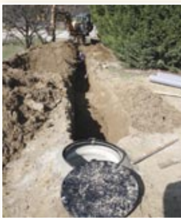
Mise en place de canalisation de collecte des eaux usées - Andance
