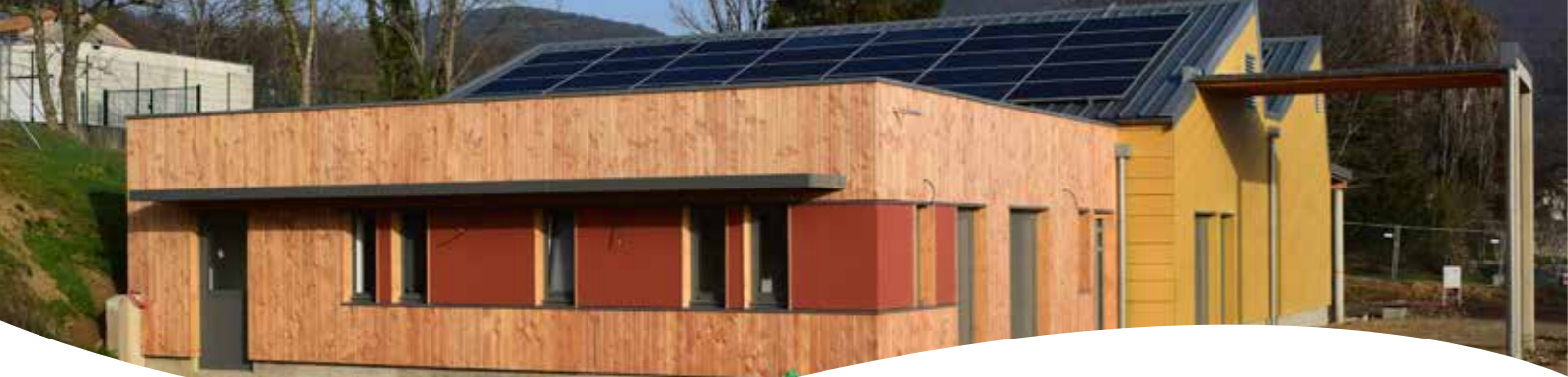
Le chantier de la cuisine centrale en janvier 2021
