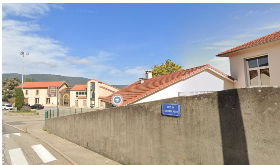
Le bâtiment de département à acquérir (au fond à gauche). Au premier plan, les murs de l'école primaire
