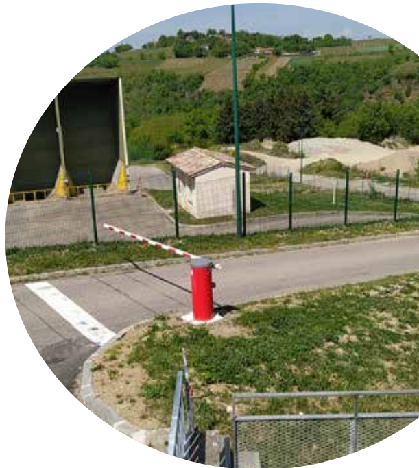
Travaux de la déchèterie à Pélussin en partie subventionnés.
