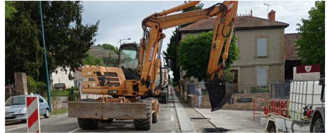
Travaux sur les conduites d'eau à Chavanay
