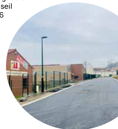
La ZAE de La Bascule à Saint-Pierre-de-Bœuf
